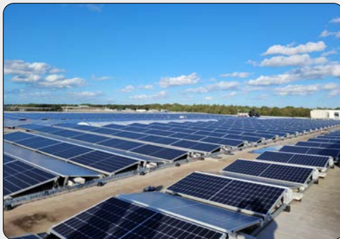
Dak VGI zonnepanelen fotografie: Rob Visser
